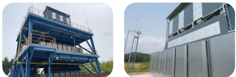
[그림 3: 열 포집 기능이 있는 1.8MW (3×600kW) 에너지 서버의 복층 구성]
